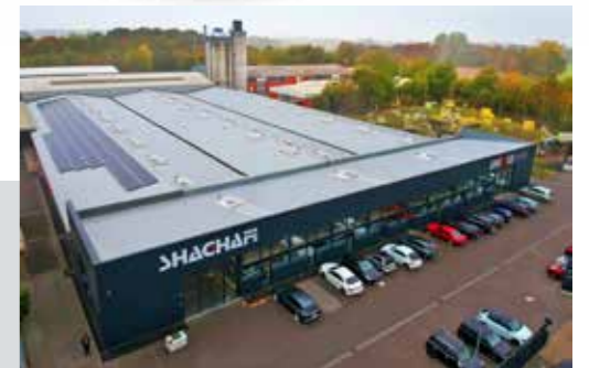
Photovoltaikanlage auf dem Dach des Firmengebäudes
